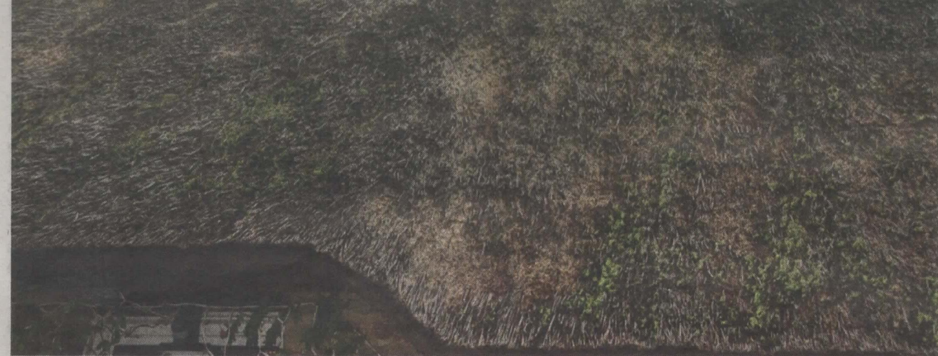
Le roseau se dégrade trop rapidement sur les chaumières
