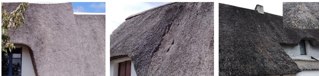
Dégradations fongiques sous forme de fissures et de creux
