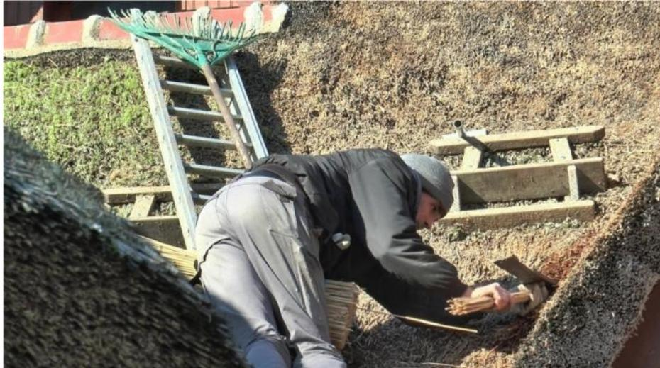
**Ill. 32.** Remaniage : réinjection de roseau dans les zones fragilisées. ©PNRGM. 2020
