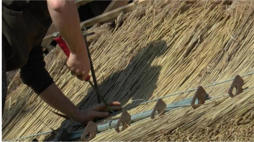
**Ill. 25.** Fixation des fils de ligature à l'aide d'un « tourniquet ». ©PNRGM. 2020
