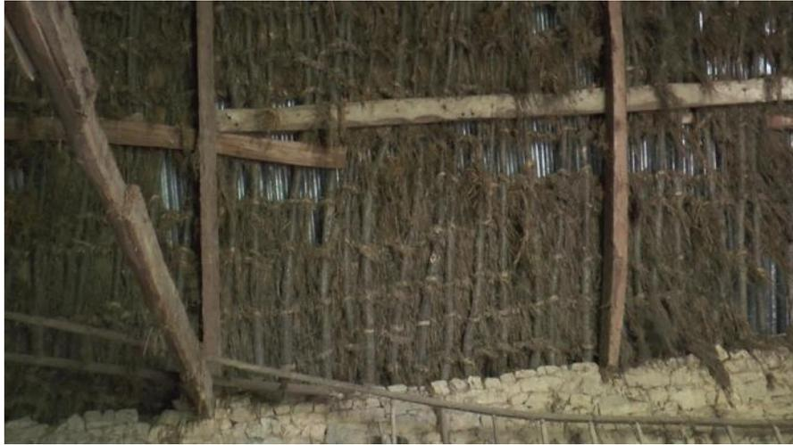
*Ill. 40. Kerverec, Ploeren : charpente ancienne recouverte de tôle dans les années 1970. ©PNRGM. 2020*
