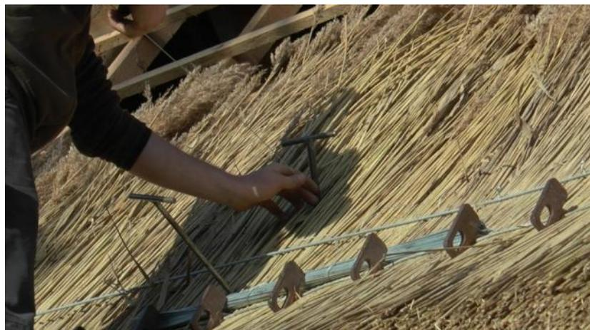
**III. 23.** Passage du fil de ligature dans la rainure de l'aiguille mâle. ©PNRGM, 2020
